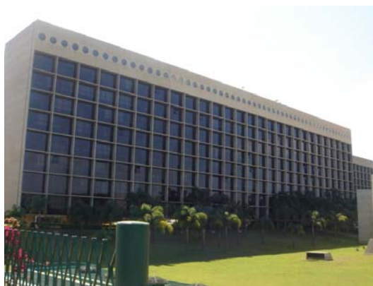
Figura 1: Vista da fachada principal do Edifício Ministros I - STJ
