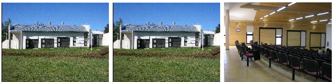
Figura 2: algunas vistas del edificio, de izquierda a derecha: fachada norte, fachada sur e interior (se aprecian los tres colectores solares indirectos).
