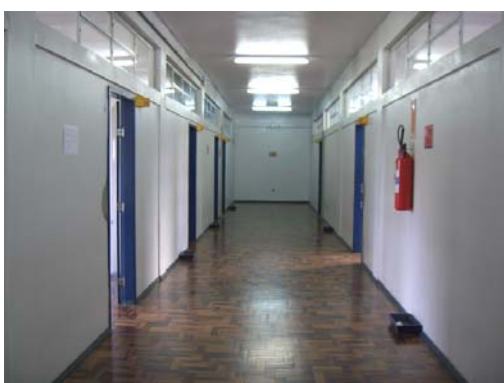
Figura 07. Corredor do CCE.
