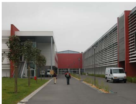
Figura 4 – Fachadas reabilitadas: leste-entrada e sul-salas de aula (abril, 2007).
