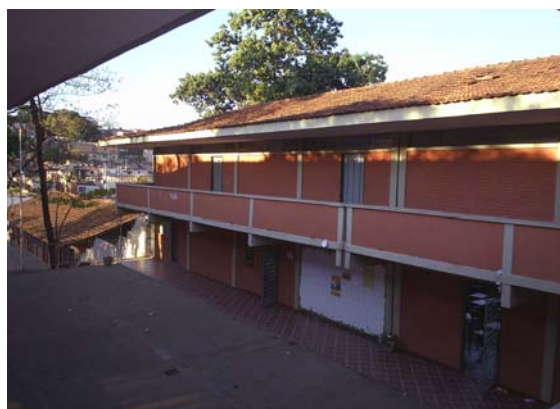
FIGURA 01: Sistema construtivo Padrão Carpe e vista do pátio, secretaria / diretoria e salas de aula.
