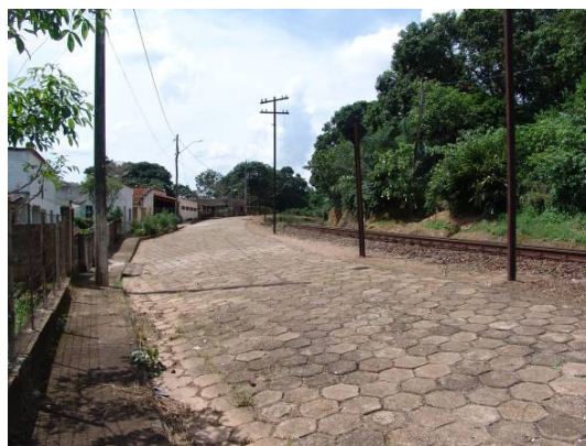
Figura 5: Vista da linha férrea a partir do ponto 25.
