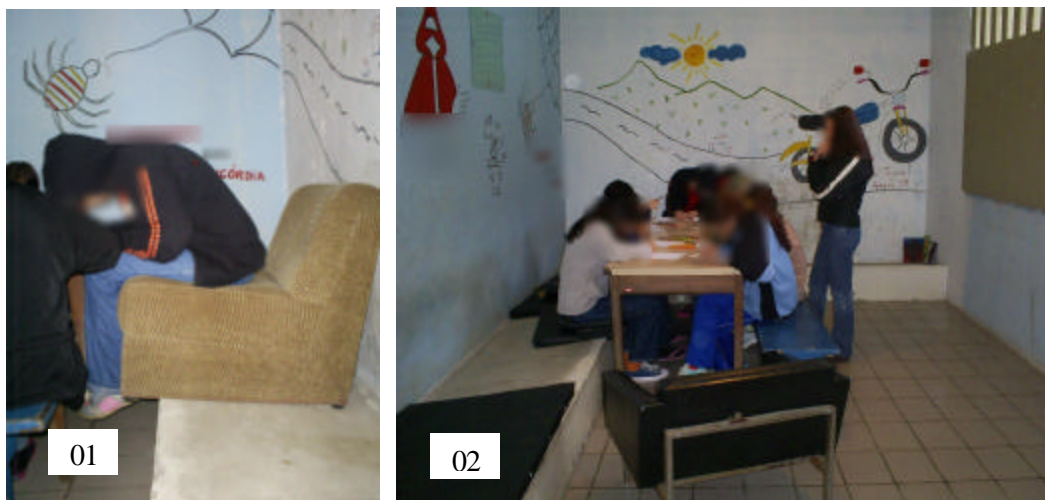
Fig. 01 – Adaptação feita para não sentar no banco de concreto e encostar-se à parede úmida – Ocupação da cabeceira.
