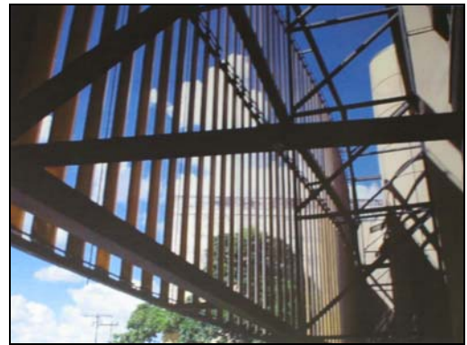
Figura 2: Estrutura de sustentação do brise
