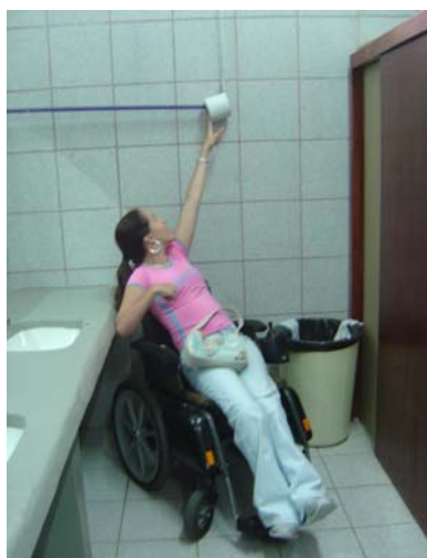
Imagem 04 - Difícil alcance dos equipamentos no banheiro
