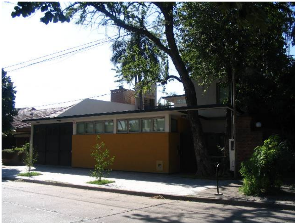
Figura 2: Vista exterior de la casa terminada. (noroeste)
