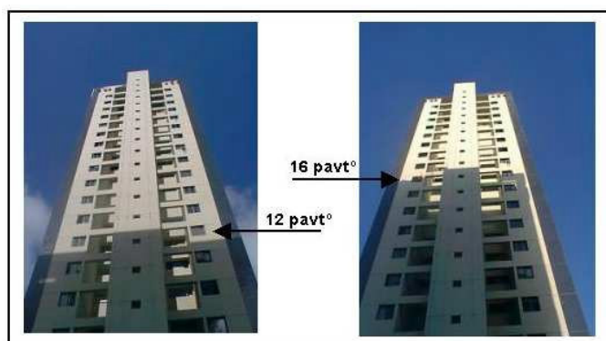
Figura 06: Fachada do Edifício D com sombra entre o 11° e 12° pavimentos às 14h e 16° pavimento às 16h – 23 de abril de 2005.
