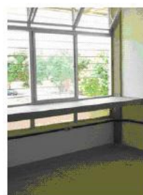
Figura 2: Interior de uma das salas do Núcleo de Pesquisa Multidisciplinar da Universidade Federal de Alagoas, com peitoril ventilado.
