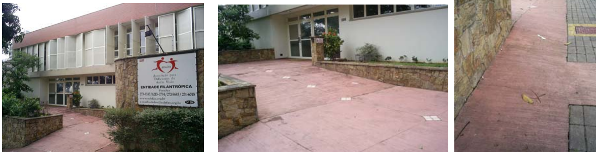
Fig. 3 – Acesso principal: rampas e calçada
