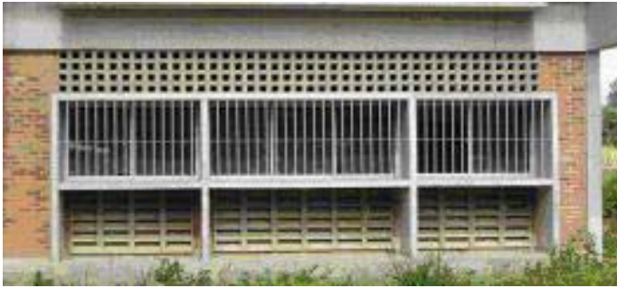
Figura 02 -Vista externa da sala de aula- Fachada leste
