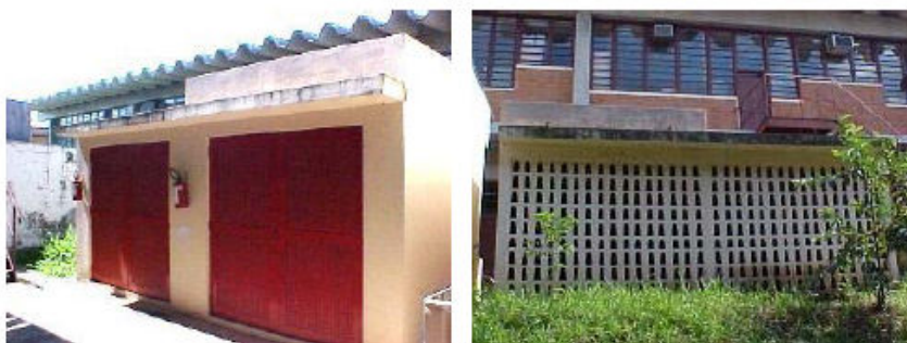
Figura 3.1: Panorama da edificação onde está implantada a cobertura verde
