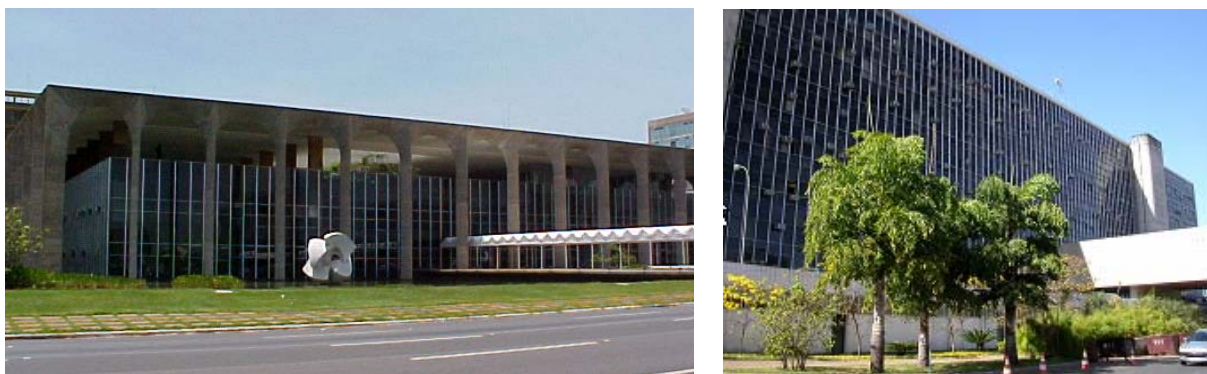
Figura 1 – Fachada principal (norte) do Palácio Itamaraty e fachada sul do Anexo I
