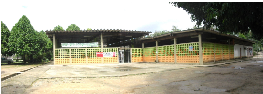
Figura 3 – Panorâmica 1 - Restaurante Universitário da UFAL – vista noroeste.
