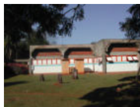
Janelas com vidros pintados. Face oeste – CCET.
