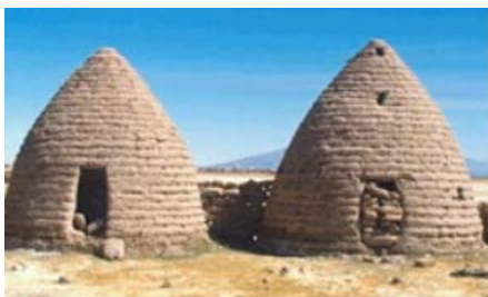
Fig. 3: Pueblo Chipaya - Altiplano: a inércia térmica do adobe amortece as acentuadas oscilações das temperaturas.
