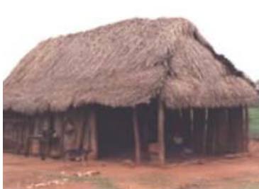
Fig. 4: Pueblo Sirionó - Região Amazônica: sombreamento e ventilação natural.
