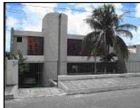
Figura 03: Casa “C” Fachada oeste
