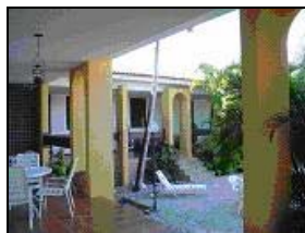
Figura 02: Casa “B” Varandas nordeste e sudeste
