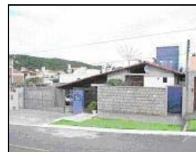
Figura 04: Casa “D” Fachada noroeste
