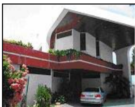
Figura 01: Casa “A” Fachada sudoeste
