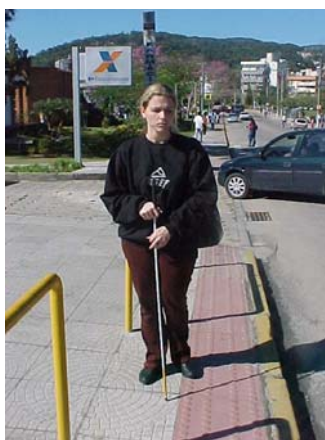
Figura 6 - Inversão do piso guia pelo piso alerta e barras, o passeio foi identificado como sendo apenas este espaço estreito e próximo ao meio fio
