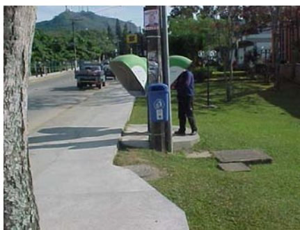
Figura 1 – Estrangulamento do passeio, ausência de piso guia e alerta, orelhão avançado sobre o passeio e desnível no piso
