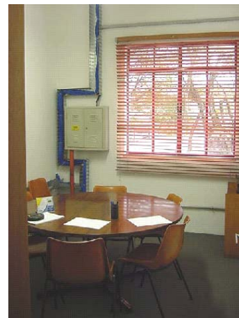
Foto 5: Vista da Sala 5
