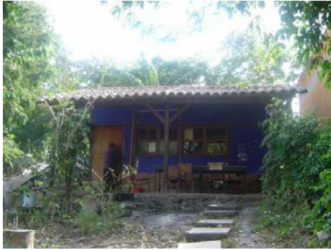
Foto 1. – Casa Experimental de Bajareque, construida en la Facultad de Arquitectura de la UNACH, 2000.
