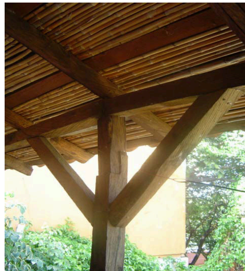
Foto 3 – Detalle de la composición del techo de la casa de bajareque.
