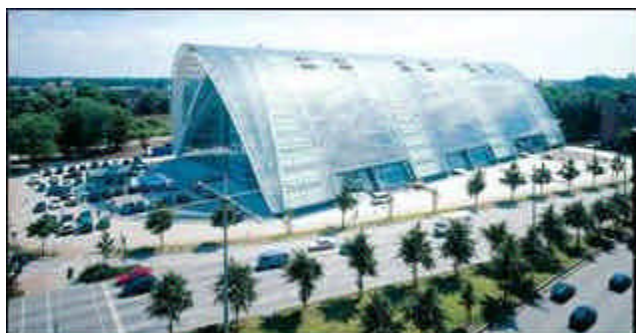
Fig. 5: Imagem do Edifício Berliner Bogen
