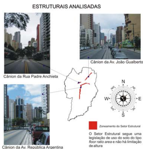
Fig. 01 – Localização do zoneamento do setor estrutural na cidade de Curitiba e as estruturais analisadas no artigo em destaque
