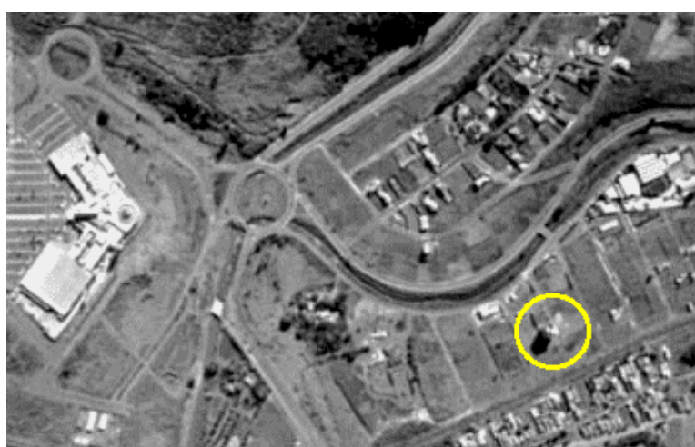
Figura 02 – Vista aérea da região, destacando a edificação analisada
