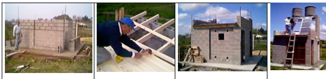
Figura 3: Imágenes del Módulo edilicio en sus etapas de construcción.
