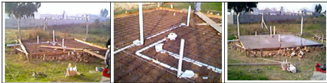
Figura 2: Imágenes del Módulo edilicio en construcción. Platea de fundación e instalaciones de desagüe
