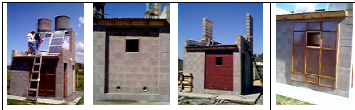
Figura 12: Colector solar de aire incorporado al muro norte del prototipo. Detalle: Superficie de colección oscura, estructura de madera y cobertura transparente de policarbonato alveolar translúcido.
