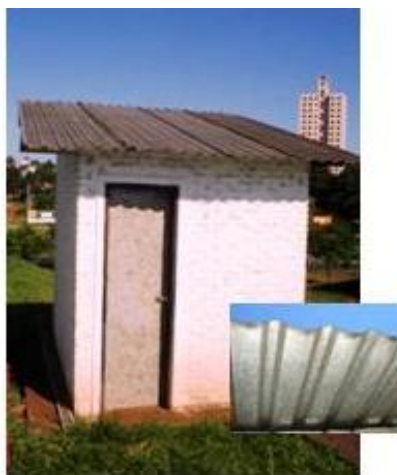
Figura 2 protótipo de aço galvanizado
