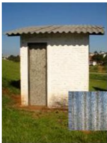
Figura 1 Protótipo com telha de material reciclado
