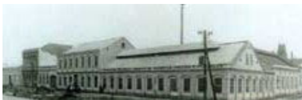
Figura 5 – Antiga indústria metalúrgica, onde o shopping foi instalado, 1878. FONTE: SHOPPING MUELLER, 2005.
