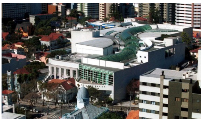
Figura 7 - Shopping Crystal Plaza, vista aérea da fachada posterior. FONTE: PMC (2005)
