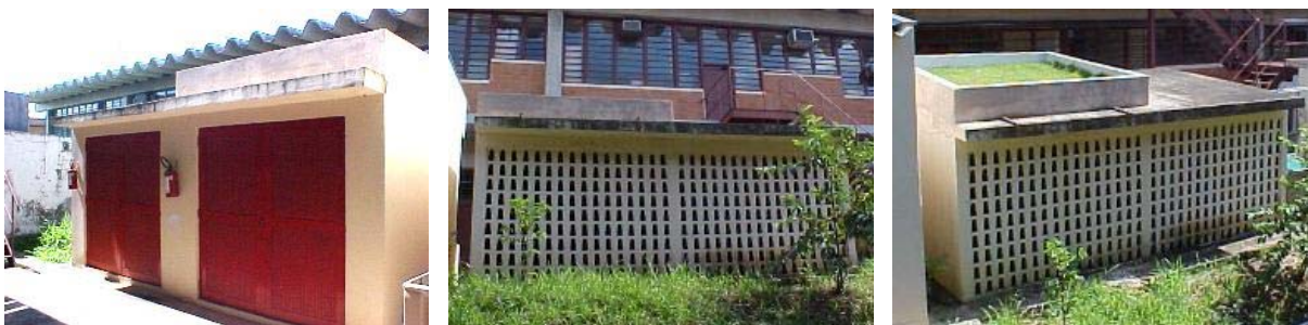
Figura 5 Vistas da edificação onde foi implantada a cobertura ajardinada.
