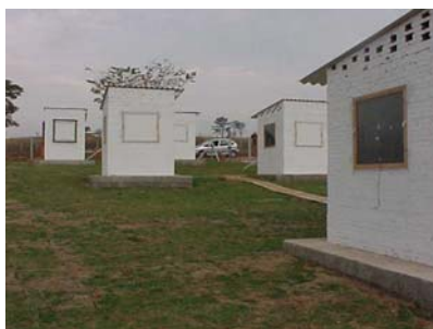
Figura 1 - Vista geral dos protótipos
