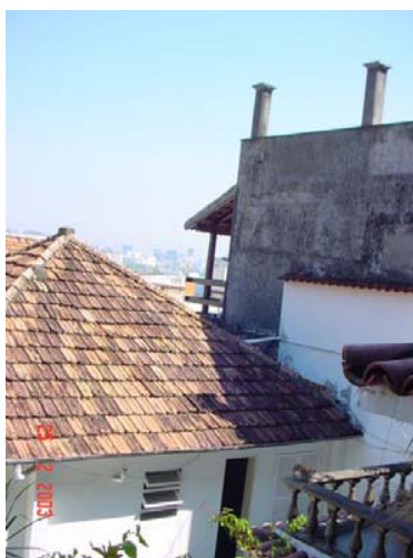
Fig 11a : Telhado antigo
