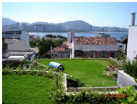
Figura 12 – Telhado novo - lajes verdes Ecohouse Urca
