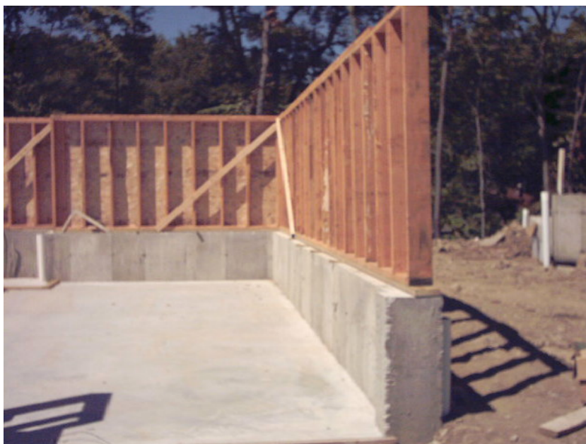
Figura 2- Sistema construtivo WLF- ossatura interna
