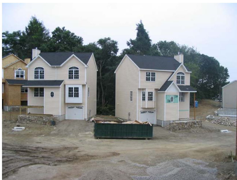
Figura 3- Sistema construtivo WLF - edificação em fase de conclusão
