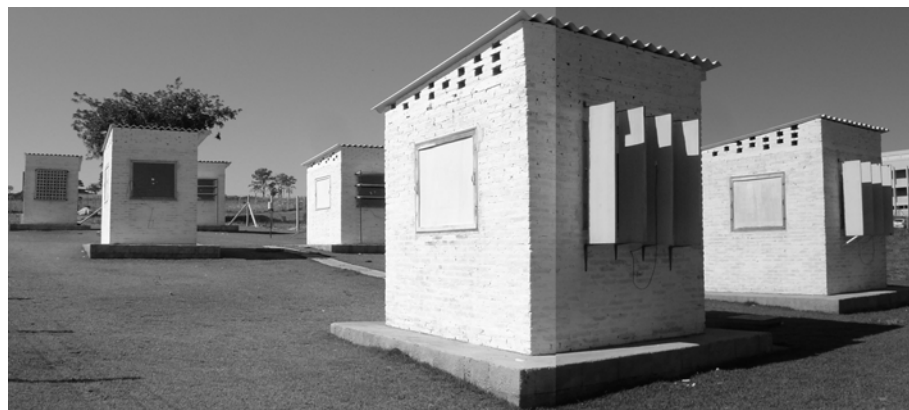
Figura 2. Vista dos protótipos com os dispositivos instalados na fachada oeste.
