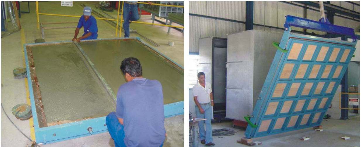
Figura 8 - Amostra de concreto sendo preparada
