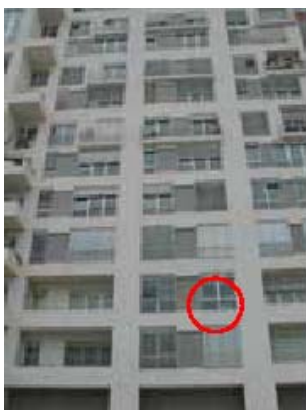
Fig. 32. Paredes de armazenamento
