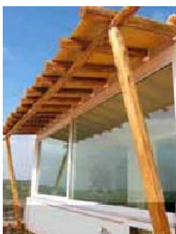
Fig. 29. Sul- 1º piso
