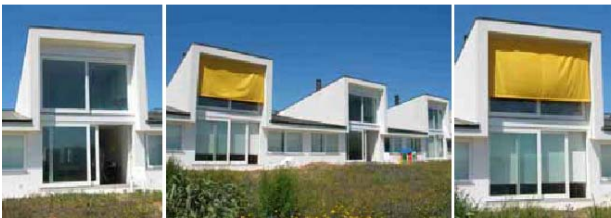
Fig. 9. Casas de Janas – Sintra –Fachada Sul Arqs. Filipa Mourão e João Santa Rita
