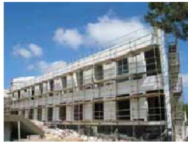
Fig. 7. Isolamento exterior
