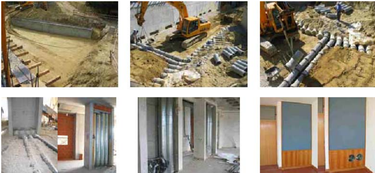
Fig.15. Fotos da construção e montagem dos tubos de arrefecimento
