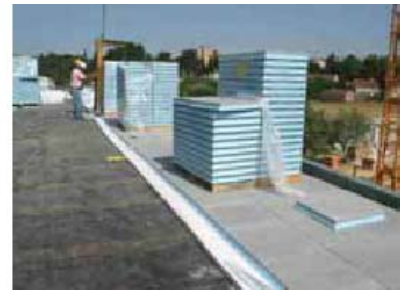
Fig. 8. Isolamento Cobertura
