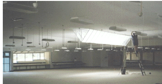
Fig. 11: Laser cut panel colocado num zenital invertido - voltado para o interior da edificação. Exemplo de alpicção na Biblioteca da Mont Cootha Herbarium , Brisbane - Austrália. Fonte: (QUT, 2003)
