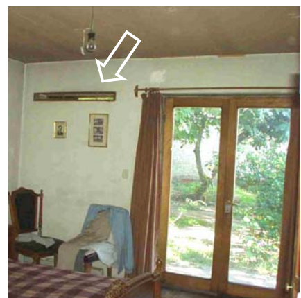
Figura 9. Imagen del interior en la que se puede observar la ventanilla del muro trombe.
