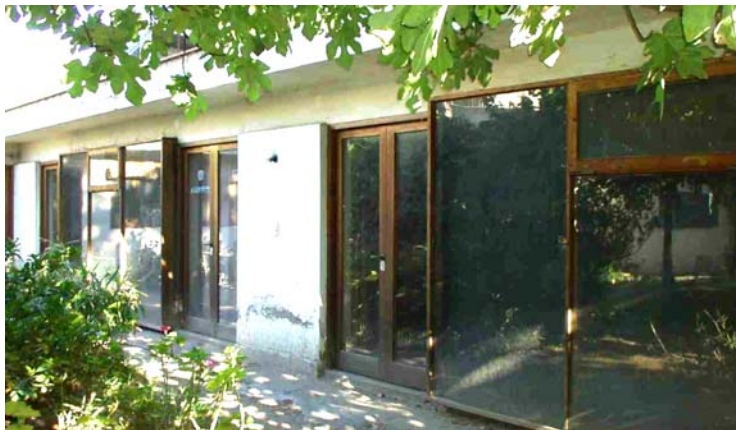
Figura 8. Imagen exterior de la pared norte en donde se observa la envolvente enriquecida por la alternancia de muros trombe, aberturas vidriadas y paredes ciegas.
