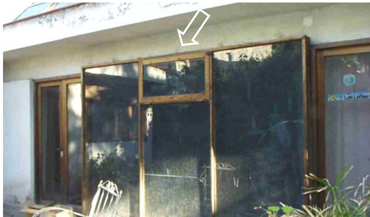
Figura 10. Imagen exterior de la pared norte donde se puede observar la ventana del muro trombe que posibilita la apertura de la cámara entre el vidrio y el muro.
