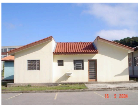
Figura 1: Vista Frontal do protótipo de Concreto Polimérico. Foto autora, 16/05/2004
