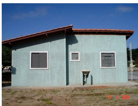
Figura 2: Vista Posterior do protótipo de Estrutura Metálica. Foto autora, 16/05/2004.
