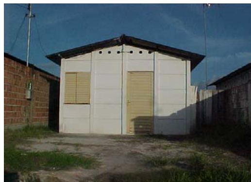
Figura 05 - Fachada principal onde localiza-se o estar/quarto - orientação oeste.
