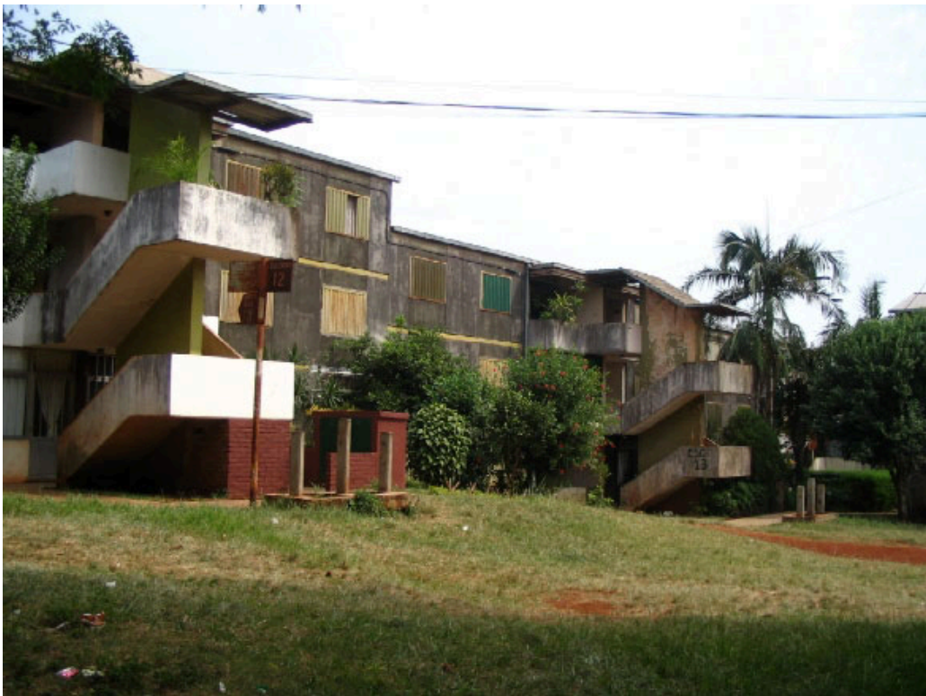
Figura 7: Vista exterior del bloque de viviendas donde se realizó una de las auditorias que se analizan en este trabajo en el Barrio Krause, Oberá, Misiones, Argentina. (21/02/2005).
