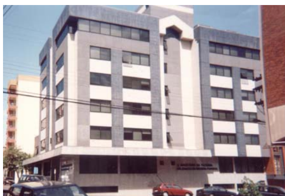
Figura 1: Vista externa do edifício
