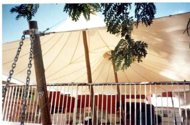
Figura 1 - Vista da estrutura de membrana tensionada.
