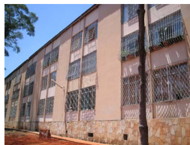
Figura 5 - Bloco R, Superquadra Sul 410 (década de 60) - Janela tradicional e reboco pintado como revestimento - 67 edifícios semelhantes, 5% do total de edifícios.
