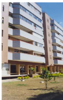
Figura 6 - Bloco E, Superquadra Norte 208 (1988)- janelas tradicionais, amplas varandas e uso de materiais cerâmicos como revestimento - 20 edifícios similares, 1% do total do Plano Piloto.
