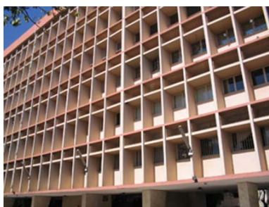
Figura 2 - bloco B, Superquadra Sul 106 (década de 60)- janelas corridas e quebra-sol de brises mistos na fachada principal; vedação por cobogós na fachada secundária; reboco pintado como revestimento - 48 edifícios semelhantes, 3% do total.
