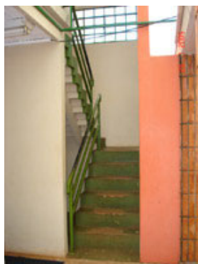
Figura 6 – Escada de acesso à Direção e Administração.
