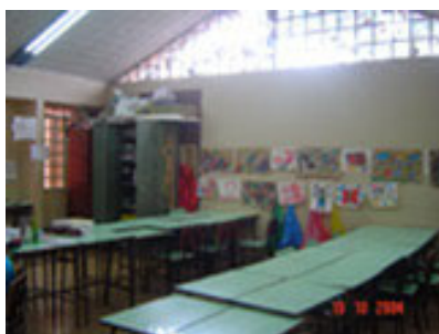
Figura 4 – Salas de aula com iluminação zenital.
