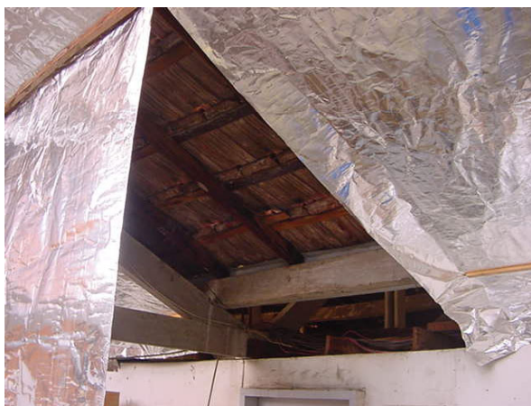
Foto 1 Vista do produto e do telhado
