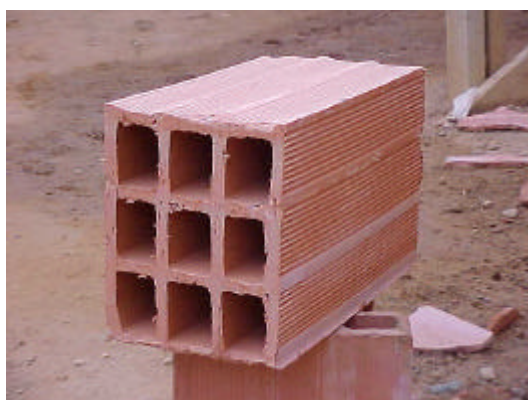
Fig. 3. Bloque tradicional de arcilla de nueve cavidades.
