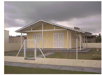
Foto 3 – Casa pré-fabricada em madeira em Fpolis SC
