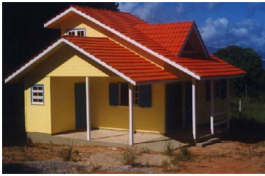
Foto 1 – Casa pré-fabricada em madeira em Fpolis SC
