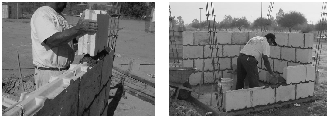
Figura 2. Aspectos del proceso constructivo con el sistema para muros LB
