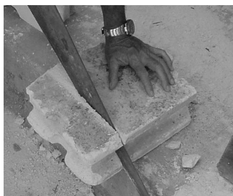
Figura 3. Corte con sierra manual de una pieza del sistema constructivo LB
