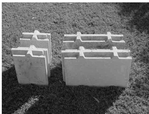
Figura 1. Elementos del sistema constructivo para muros LB
